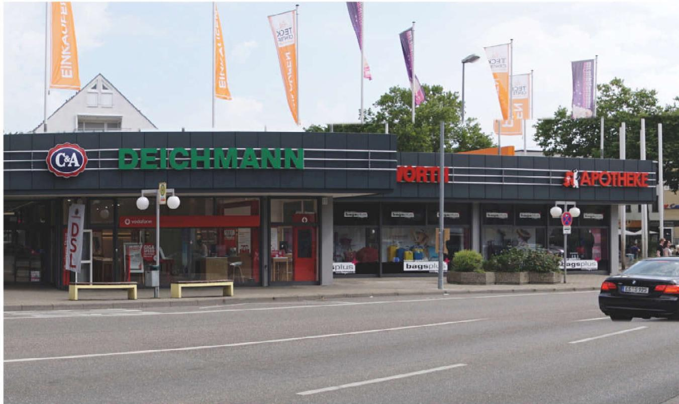
Die neue, eloxierte Aluminiumverkleidung der Attika mit einem Rohrträgersystem zur Aufnahme der neuen Werbeanlagen der Mieter gibt dem Center eine zeitgemäße Ausstrahlung.
