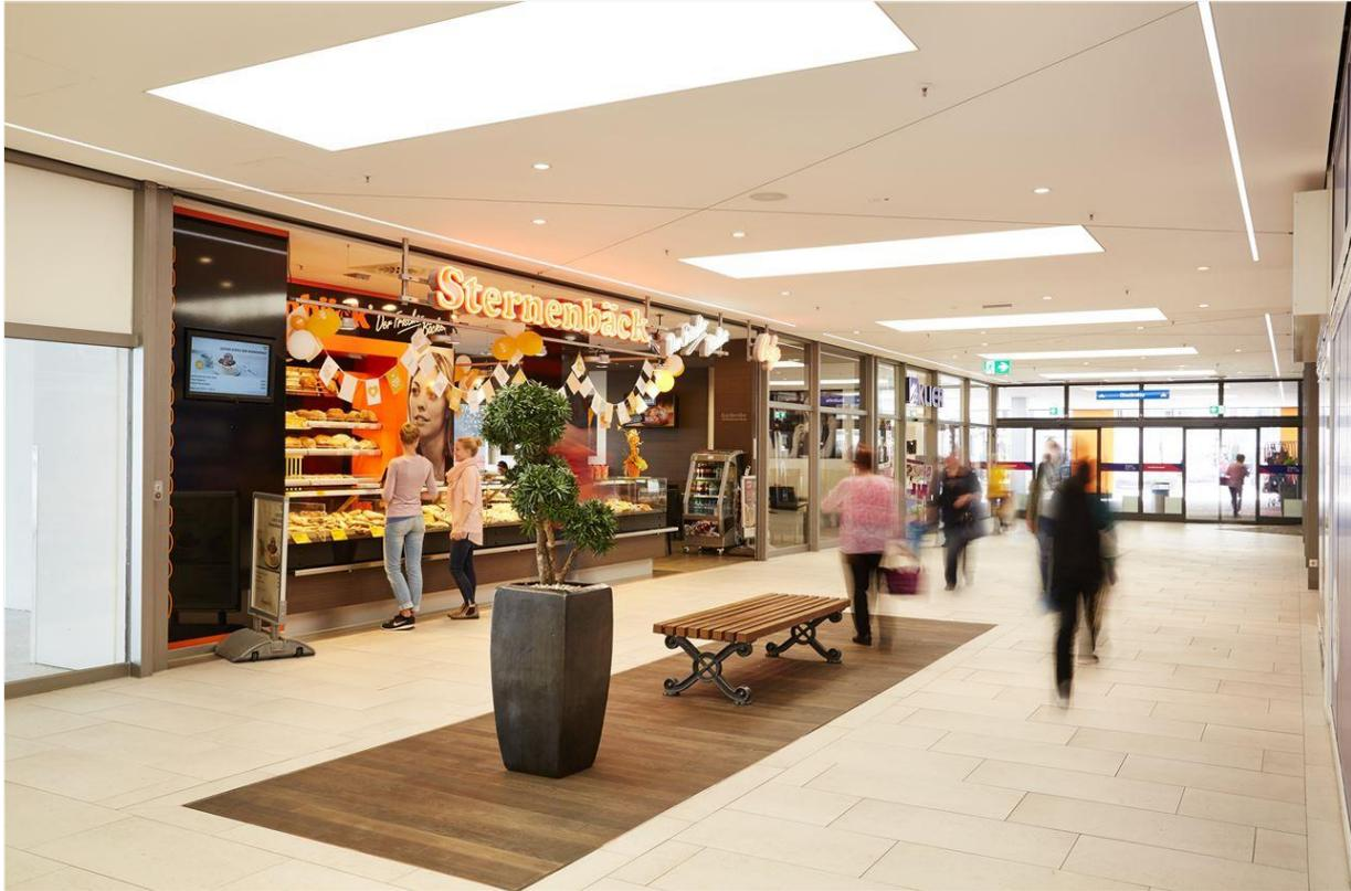
Das Beleuchtungskonzept im Einkaufszentrum wurde nach ökologischen Nachhaltigkeitsaspekten überarbeitet. Durch den Austausch der Leuchtstoff-Einzelleuchten der Mall in LED-Großfeldleuchten und konventioneller Downlights in LED-Spots sowie durch den Einbau von LED-Lichtbändern konnte nicht nur der Leuchtmittelverbrauch gesenkt, sondern vielmehr eine Energieeinsparung und somit eine Senkung der Stromkosten um ca. 20 % erzielt werden.
