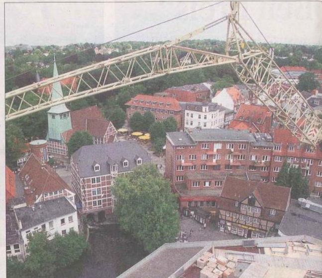
Bis zu 55 Meter in die Höhe muss der Teleskoparm die Etagentelle aus Stahl heben. Der Kranführer muss sich auf die Anweisungen verlassen, die er über Funk erhält. Fotos: Leimig
