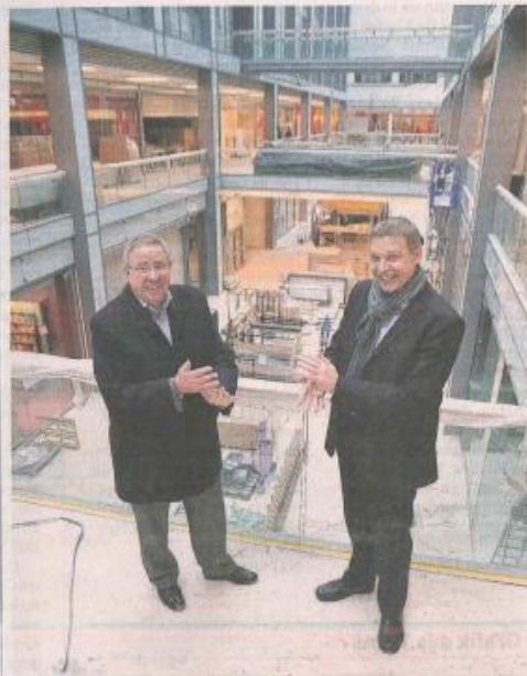
Klaus Schröder (li.) und sein Nachfolger Uwe Eigenbrod sind derzeit täglich auf der staubigen Baustelle unterwegs. Foto: Herbst
