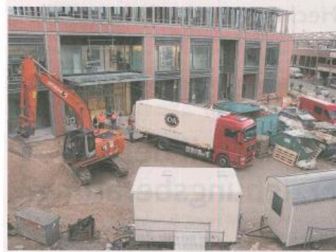
Vorn CCB-Haupteingang ist derzeit wenig Platz für Liefer-Lkw. Sie müssen sich den Raum vorerst noch mit Baumaschinen und Arbeitern teilen. Foto: Schütz
