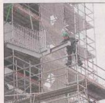
Ein Arbeiter dirigiert das Geländer an die richtige Position.
