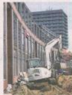
Auch von der B 5 könnte angefordert werden. Derzeit wird hier aber noch gebuddelt.
